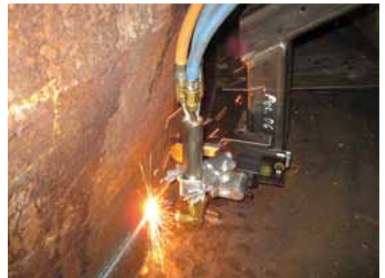
Fernbedientes Trennen des RDB in Ober- und Unterteil Remote-controlled flame-cutting of reactor pressure vessel into top and bottom parts
