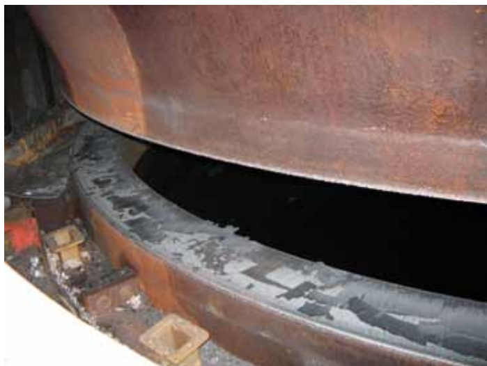
Getrennter RDB/Ober- und Unterteil Top and bottom parts of the cut reactor pressure vessel
