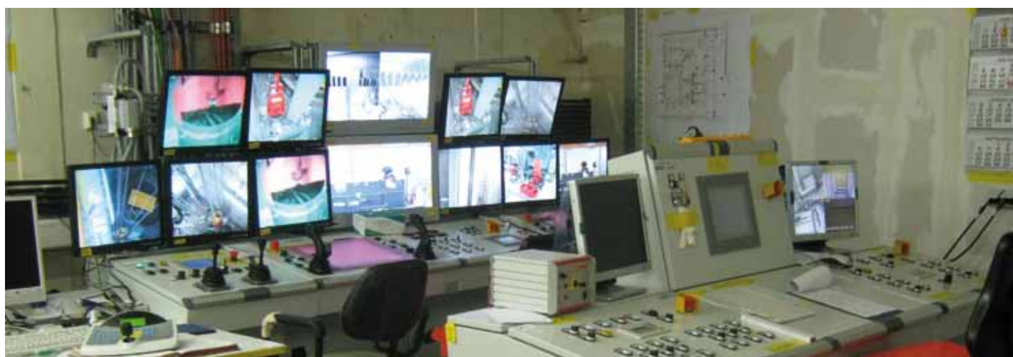
Steuerstand für den fernbedienten Rückbau/ Control room for remote-controlled dismantling activities
